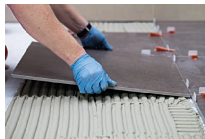
PCI Flexmörtel® S2 to idealna zaprawa do wyklejania płytek na młodych podłożach mineralnych.
